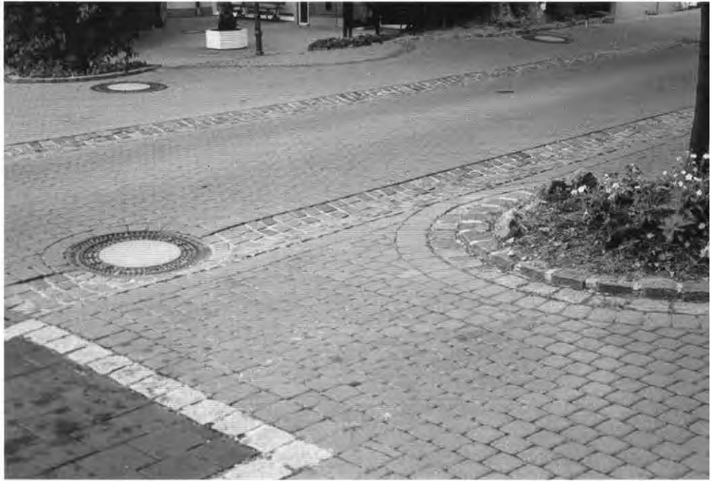
Foto 2: Plataforma única mixta con dos rigolas limitando la franja de tráfico rodado
