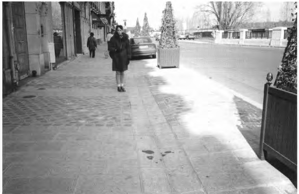
Foto 3: Itinerario peatonal con rigola separando la banda libre de la franja que contiene el mobiliario urbano
