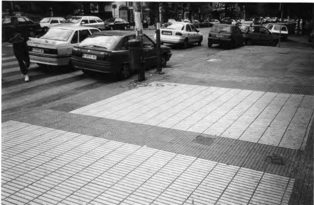
Foto 8: Vado de tres rampas con dos bandas señalizadoras laterales construido con "pavimento" de botones" de color contrastado con el itinerario peatonal en que se ubica
