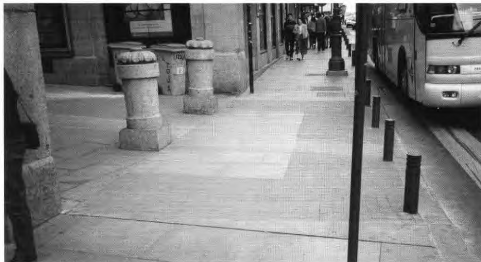
Foto 7: Vado de tres rampas con dos bandas señalizadoras laterales, construido con adoquín de granito de textura rugosa. Igual que en el caso anterior, la instalación de bolardos no resulta conveniente para personas con deficiencias visuales
