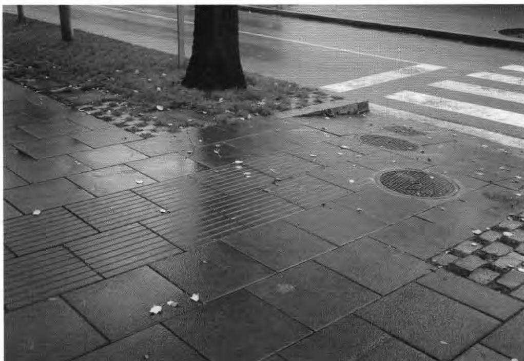
Foto 11: Vado de una rampa tipo “Barcelona” con franja señalizadora central, sin contraste de color con el pavimento circundante
