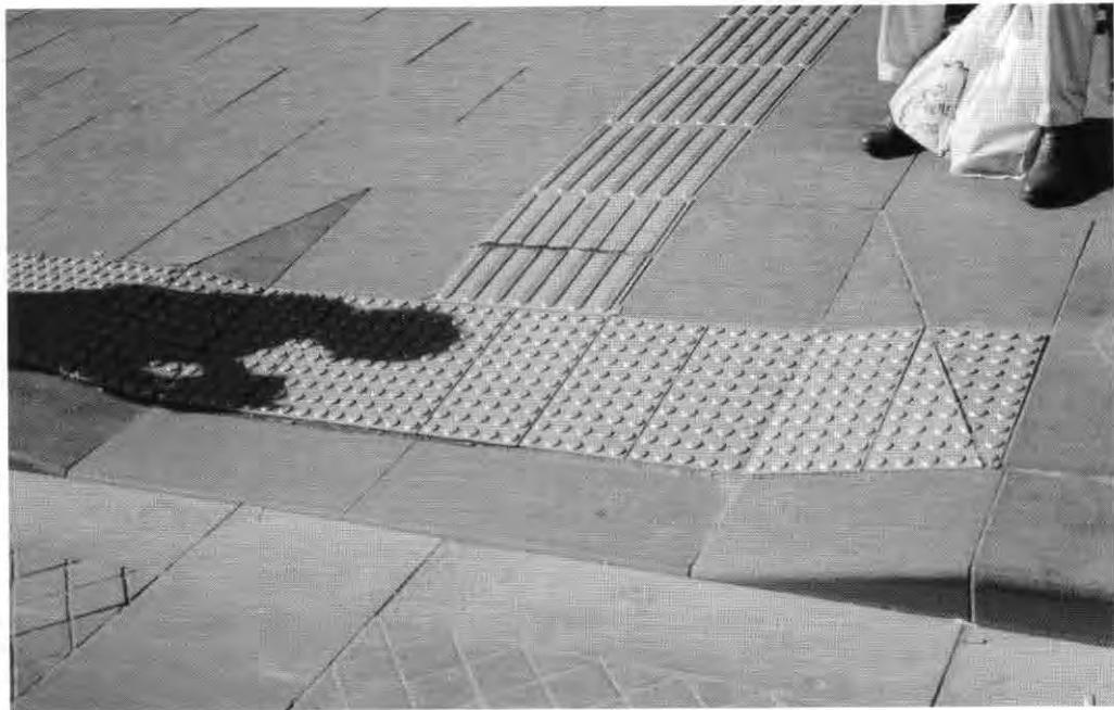
Foto 2: Franja direccional que conduce a un vado que permite el acceso a autobuses urbanos
