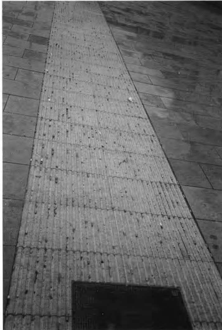
Foto 4: Detalle de franja direccional
