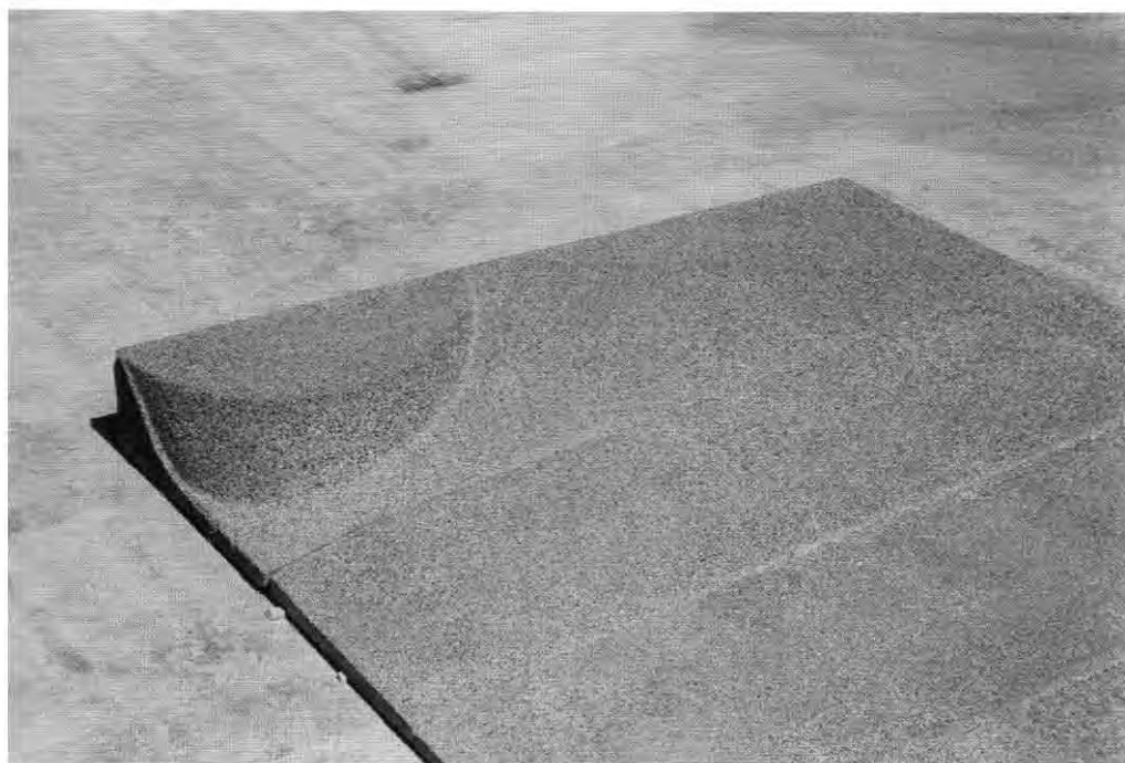
Foto 12: Detalle de las piezas de durogranito abujardado del vado prefabricado VL. 96
