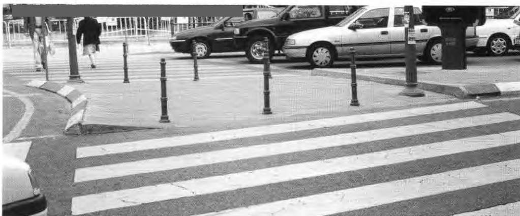
Foto 3: Isleta con pavimento diferenciado en textura y color, y rebajada al nivel de la calzada. Los bolardos impiden que los vehículos invadan la isleta pero no son recomendables para las personas ciegas o con deficiencias visuales
