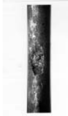
Figura A.9 Picadura debida a la presencia de cloruros en un cable de pretensado
