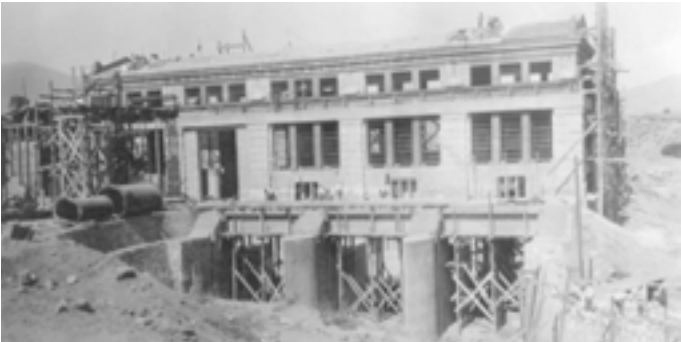
1928. Construcción C.H. Puente Nuevo (Ávila)
