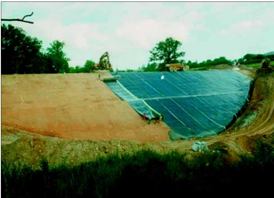
▲ 10 - Placing a bituminous geomembrane. (text p. 81).
