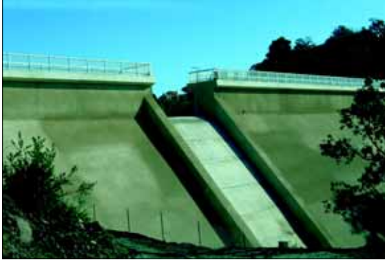
◀ 21 - Concrete gravity dam. (text p. 116).
