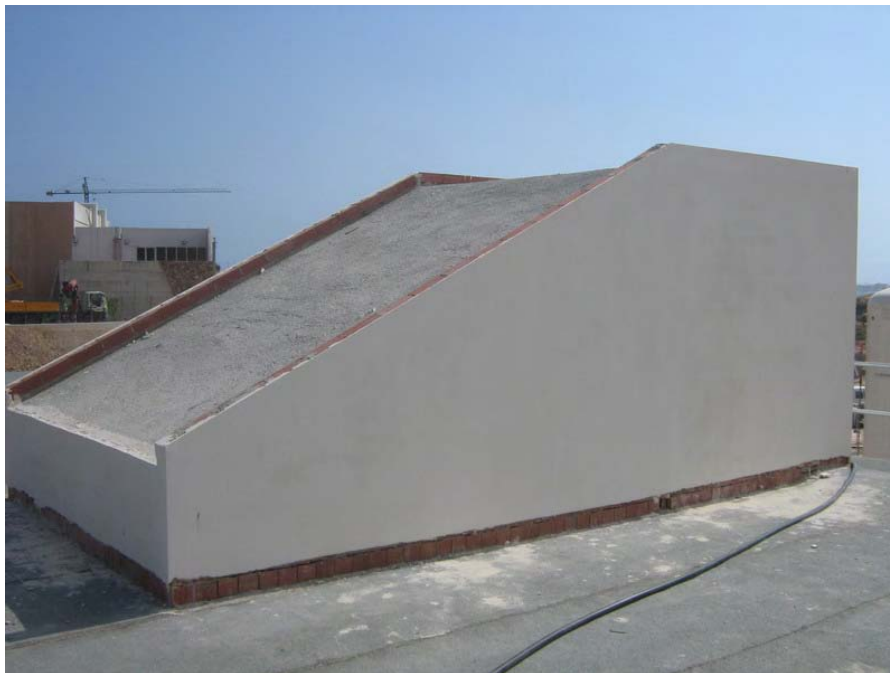
CASETA EN CUBIERTA PARA ACCESO AL INTERIOR DE LAS CÁMARAS
