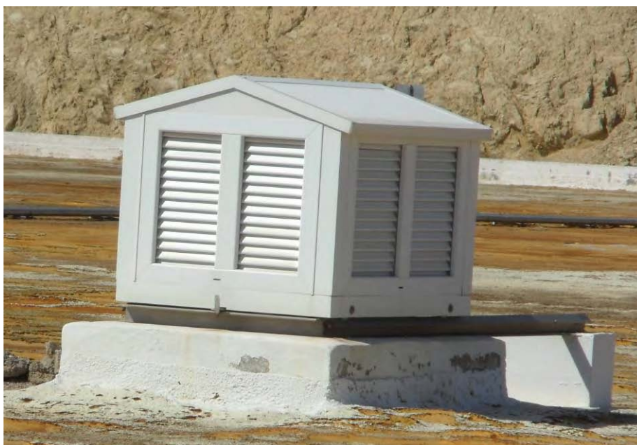
DETALLE DE COPETE DE VENTILACIÓN (RESPIRADERO)
