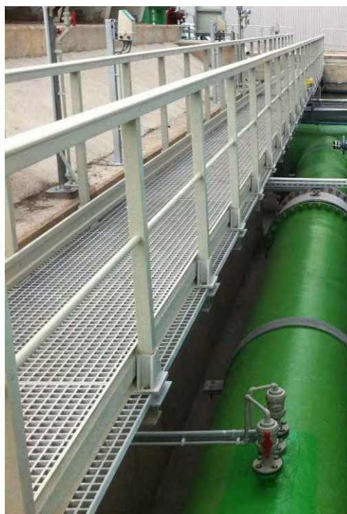
DETALLE BARANDILLAS CON RODAPIÉS Y TRAMEX (PRFV)
