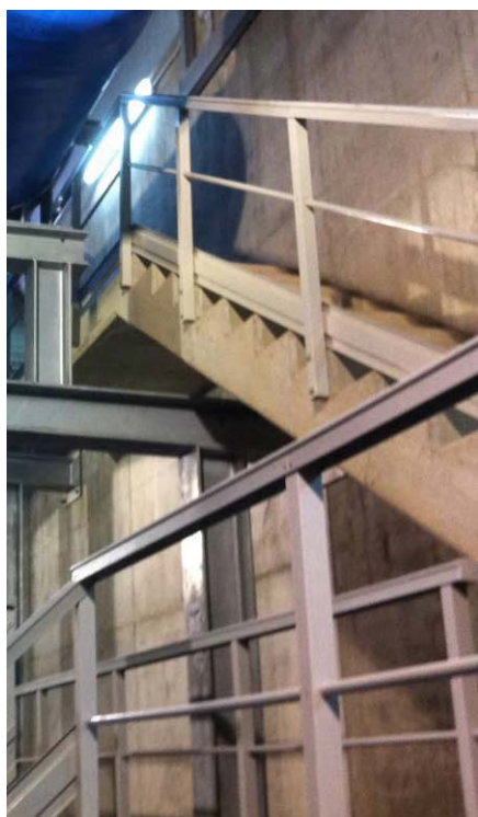
DETALLE BARANDILLAS CON RODAPIÉS Y TRAMEX (PRFV)
