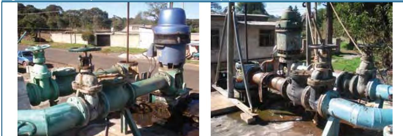
Este problema es recurrente y reduce de manera significativa la eficiencia porque incrementa las pérdidas (internas y externas) de la bomba tal y como se explicó en el inciso 4.1.3.1 de este Manual.
