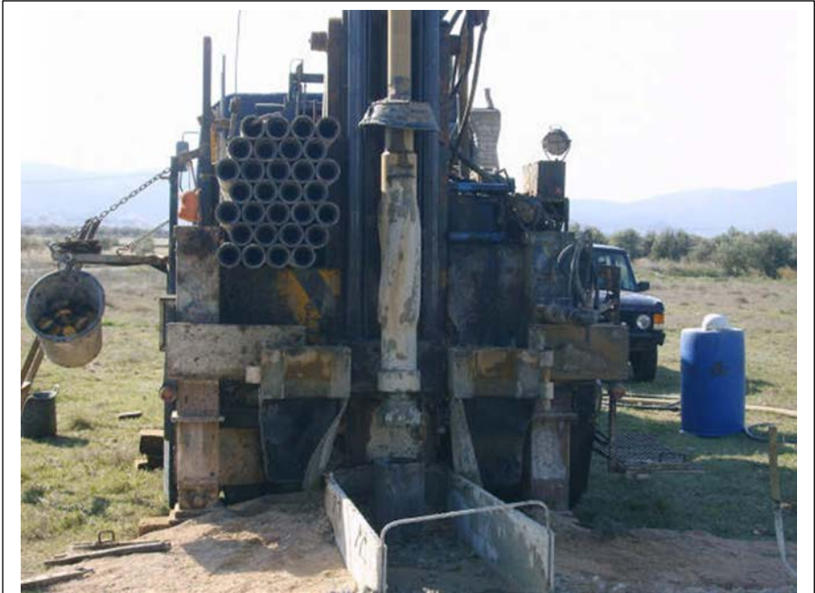
Perforación de un sondeo hidrogeológico.
