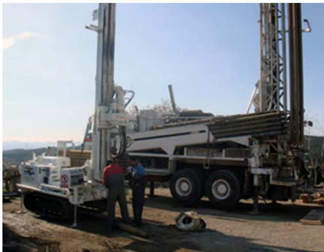
Trabajos de investigación hidrogeológica. Sondeos de reconocimiento.
