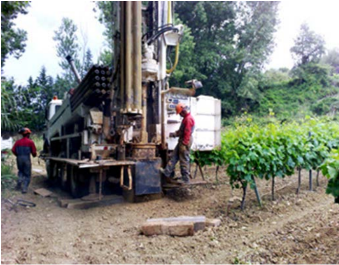
Trabajos de investigación hidrogeológica.
