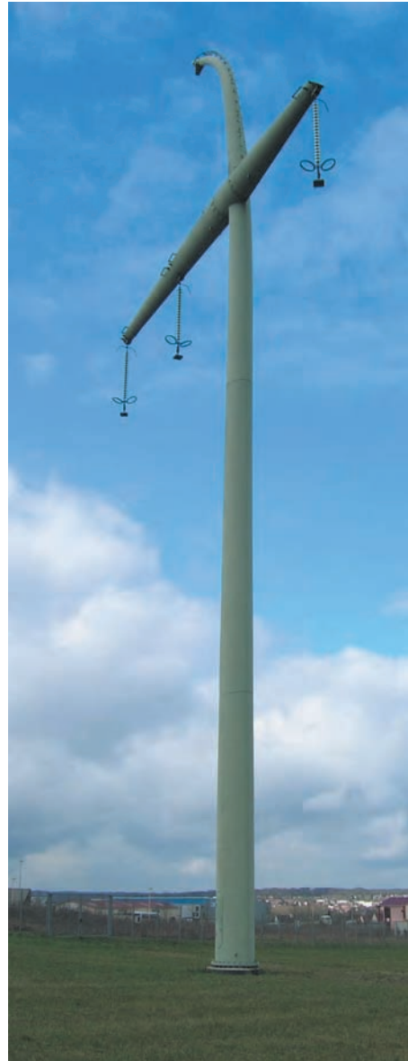
figure 13 Pylône de type Fougère Conception : I. Ritchie (architecte), K. Gustafon (BE) RFR.
