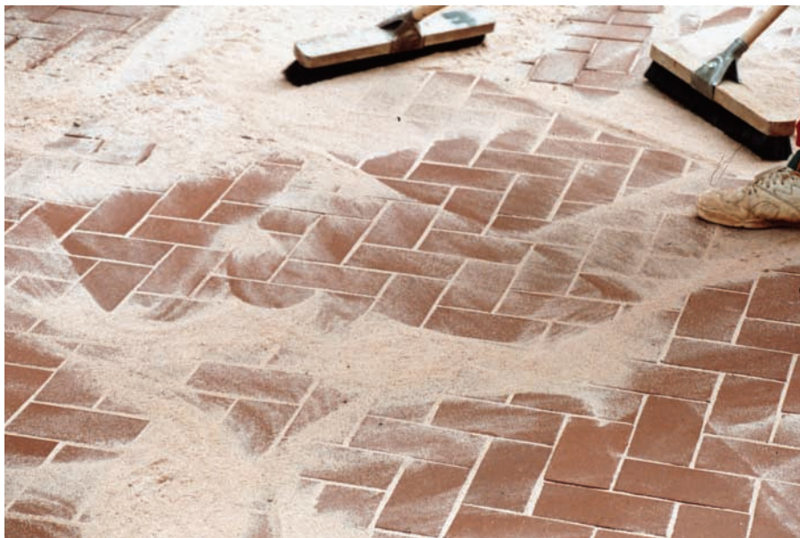
Detalle llenado juntas
