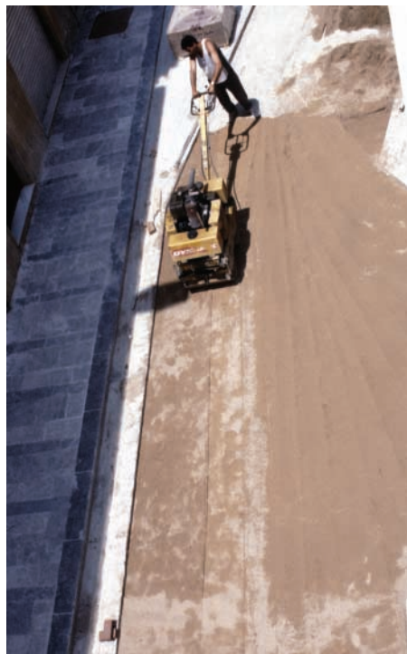
Compactación de la capa de arena
