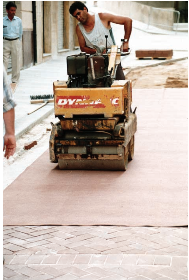
Compactación del adoquinado
