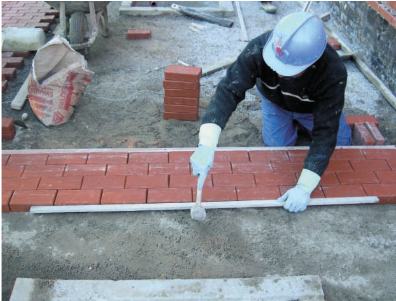
Alineación de adoquines golpeando con maceta
