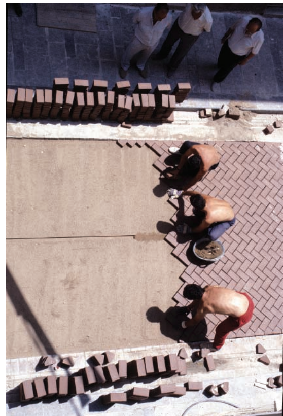
Colocación en espiga por varios operarios
