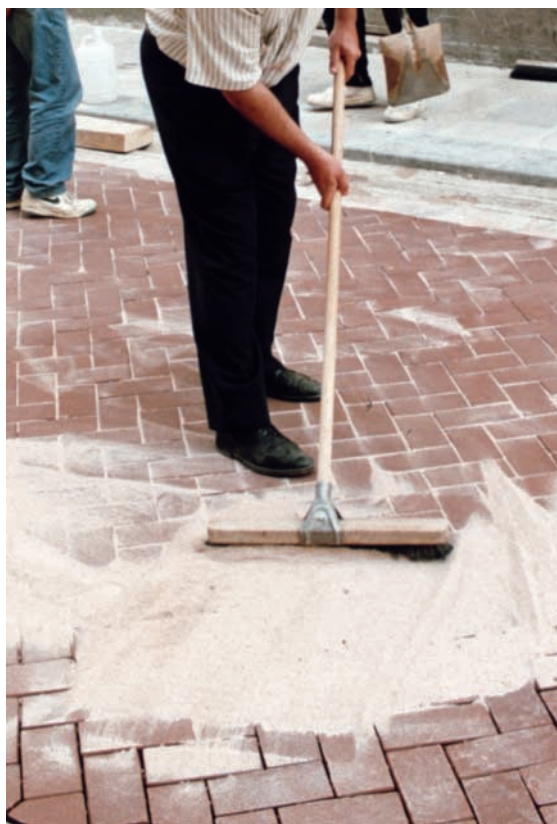
Relleno de juntas mediante barrido
