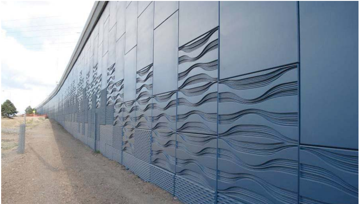
➔ Figura 1.- Muro con acabado realizado con poliuretano (Australia).
