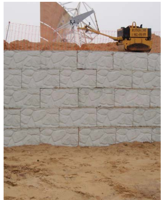
Figura 7.- Muro de bloques imitación piedra (Planta Termosolar de Majadas - Cáceres).
