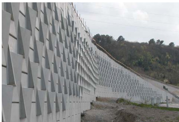
Figura 14.- Acabados con resaltos (Autovía A-89 – Francia).
