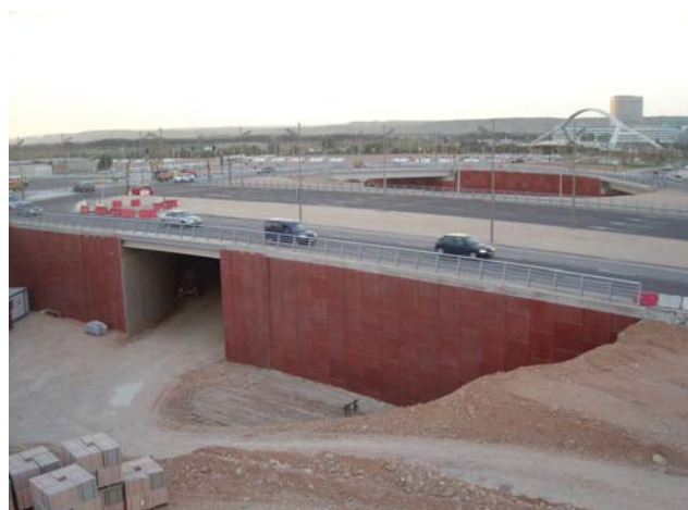
Figura 9.- Muros y estribos coloreados en los accesos a la estación de Delicias de Zaragoza.
