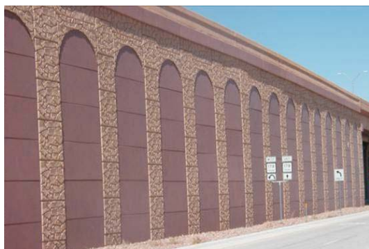
Figura 12.- Muro-aleta simulando un acueducto (Estados Unidos).
