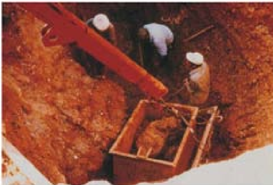
EXTRACCIÓN DEL MATERIAL REMOVIDO
