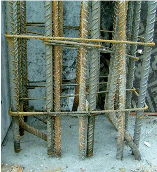
Es muy común ver cómo en obra, aparte de realizar un grifado inadecuado, posteriormente se procede en muchas de ellas al “desgrifado” de barras para rectificar excesos o enderezar barras grifadas de forma errónea, o proceder a un nuevo grifado prácticamente en la misma sección. Como se ha comentado, visto y mencionado en la Instrucción, esta práctica es muy perjudicial, ocasionando daños que producen la “eliminación” de dichas barras al quedar seriamente comprometidas sus prestaciones mecánicas.
