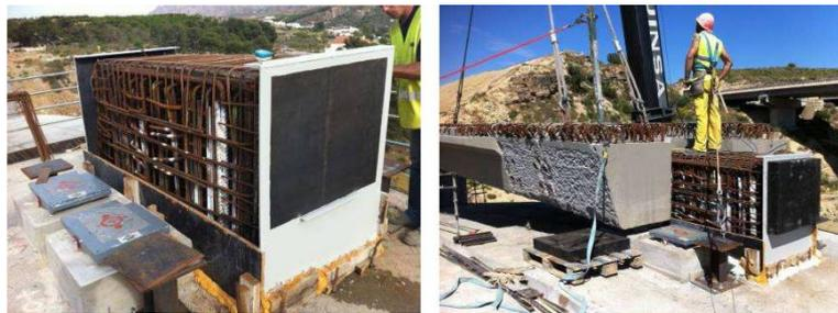
**Figura 8. Estado de los tetones previo a su hormigonado**
