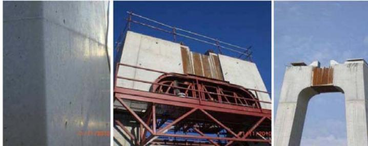
**Figura 6. Detalle de acabado del hormigonado en los dinteles**
