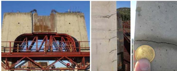
**Figura 7. Detalle de las fisuras aparecidas tras el primer desencofrado**
