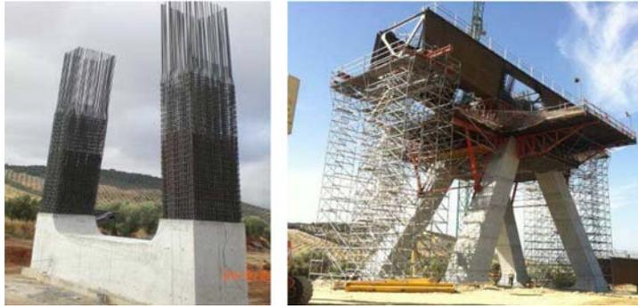
**Figura 1. Tipología de pilas en el Viaducto de Archidona. Izqda. Pila tipo. Dcha. Pila central en delta (punto fijo)**
