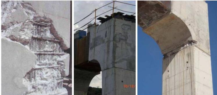
**Figura 3. Coqueras y desperfectos de acabados en dinteles hormigonados con hormigón convencional**
