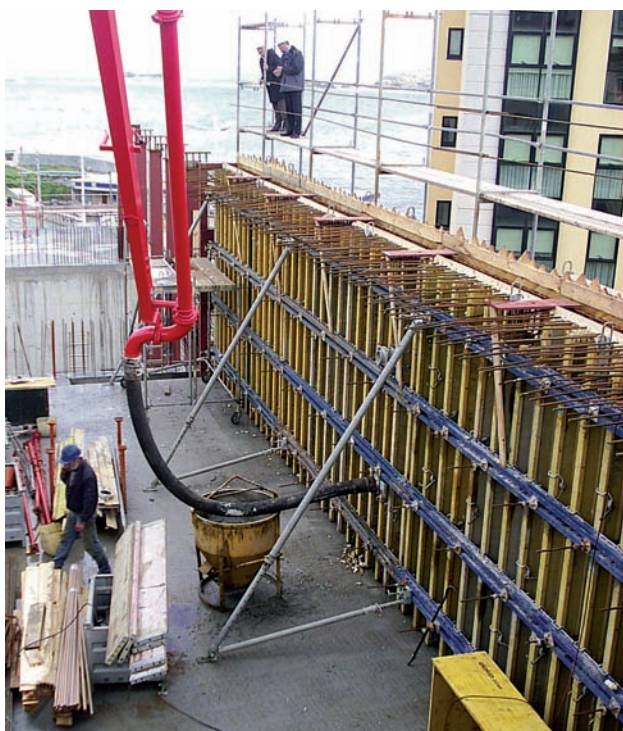
Figura 4.- Encofrado y colocación de hormigón autocompactante mediante bombeo tradicional.
