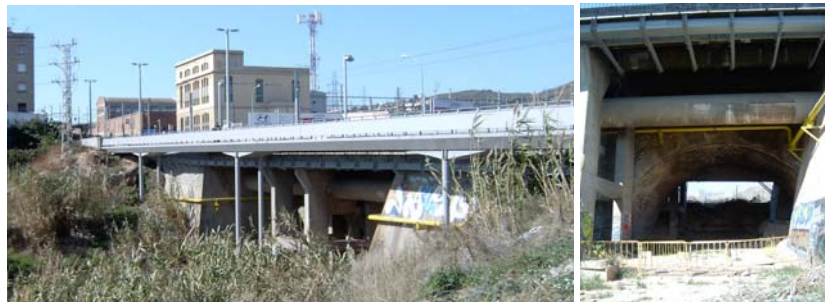
Figura 4. Puente complejo de inventariar y de inspeccionar.
