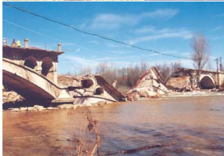
Figura 5. En la parte superior izquierda, giro de eje longitudinal en un puente de tramo recto; en la parte inferior izquierda, colapso de un puente de bóvedas de hormigón en masa como consecuencia del giro inducido en una pila al producirse la socavación durante una avenida. A la derecha, explicación cualitativa de la diferente importancia que tiene un giro de la cimentación en tramos rectos, isostáticos e hiperestáticos, y de bóvedas (casos a y b c) respectivamente.
