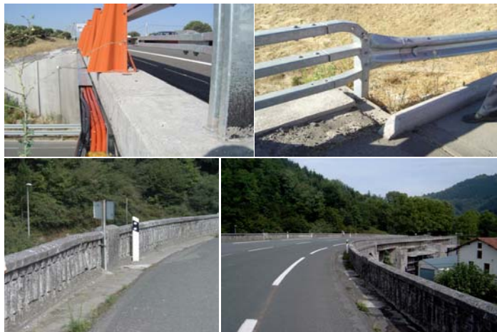
Figura 24. Situaciones diversas de los sistemas de contención de vehículos en puentes.
