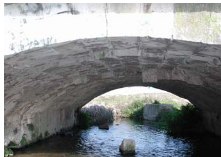
Figura 21. Daños de durabilidad en puentes de fábrica.
