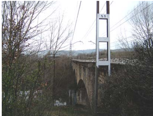
Figura 19. Vista de la imposta de un puente de fábrica: si no es horizontal, como en la foto, síntoma probable de movimiento de cimentación y desórdenes en las bóvedas.
