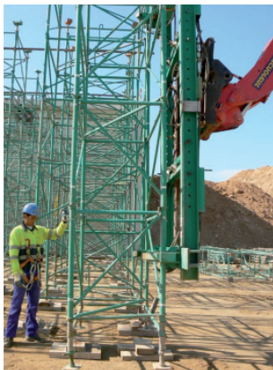
4. Soluciones técnicas para mejorar las condiciones de trabajo de actividades de montaje de cimbras cuajadas y la colocación de bordillos (25).
