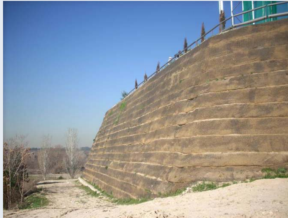
Muro reforzado una vez finalizado
