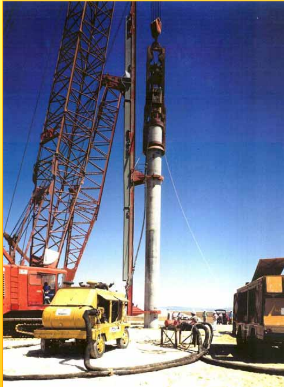
Hinca de un pilote RAYMOND \varnothing 66", en los Puentes de la Variante de Puerto Real y el Puerto de Santa María (Gentileza de Dragados)
