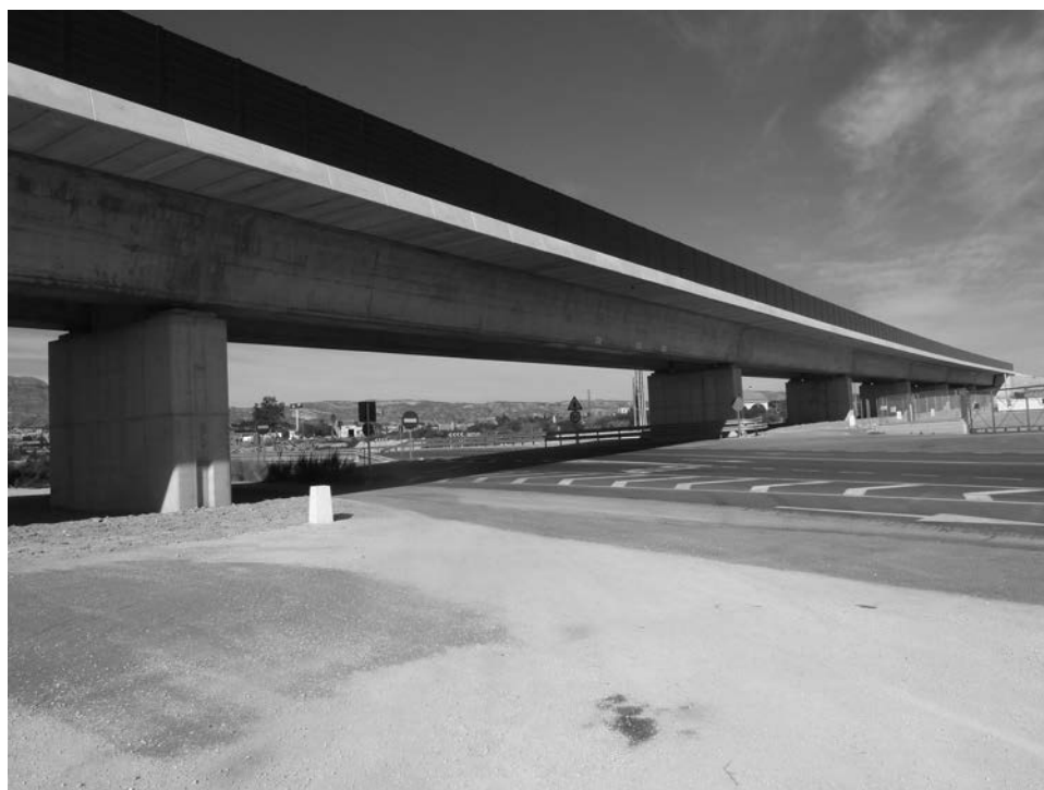
Figura 5. Fotografía Viaducto sobre CV-875.
