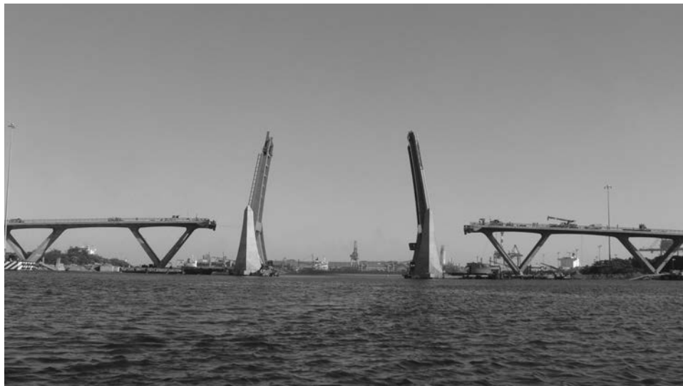
Figura 3. Puento Albatros. Tramo basculante.
