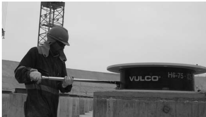
Figura 11. Apriete de los pernos inferiores de anclaje.
