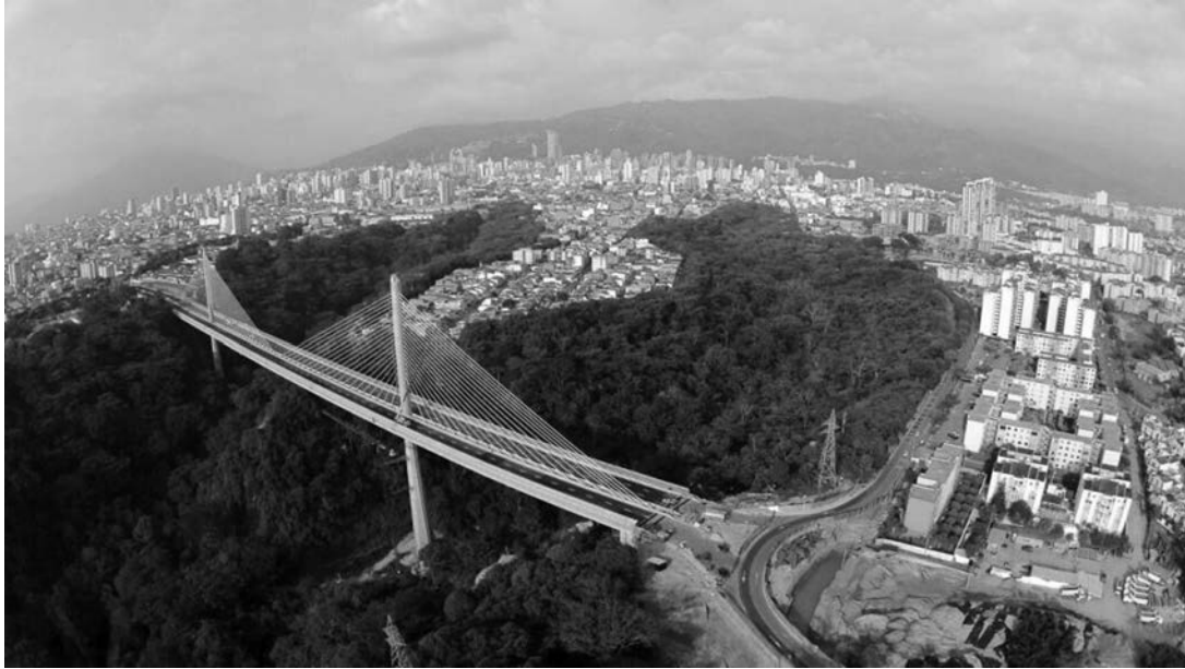
Figura 7. Viaducto Carrera Novena. Vista general del puente.
