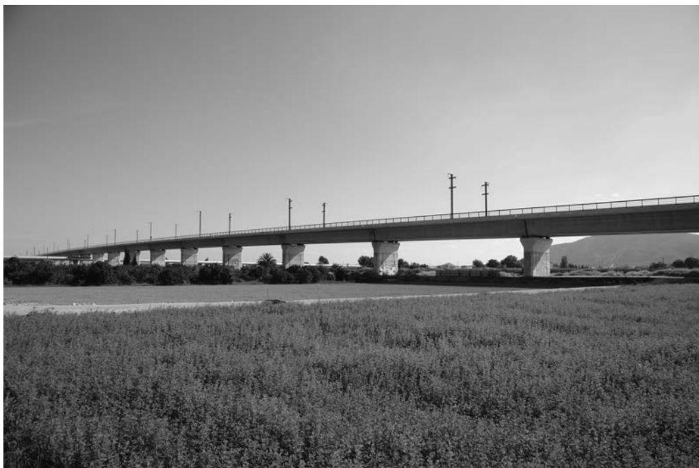
Figura 13. Fotografía Viaducto sobre Tránsito Tajo-Segura.
