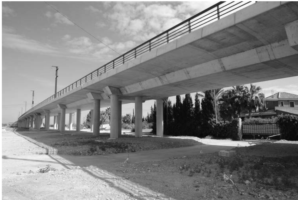
Figura 16. Fotografía Viaducto sobre CV-95.
