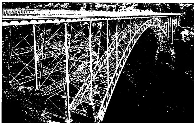
Figura 3: Viaducto de El Pino sobre el río Duero, en Zamora, luz: 120 metros; altura sobre el río: 90 metros. Ing. Ribera, 1914.
