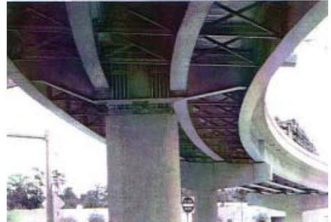
Riostra metálica. Puente terminado
