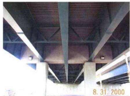
Riostra de hormigón pretensado. Puente terminado
