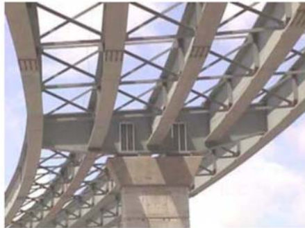
Riostra metálica. Puente en construcción
