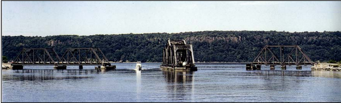
Fig. 17. Puente flotante y giratorio en la confluencia de los ríos Harlem y Hudson en Nueva York, 1995 [4].
