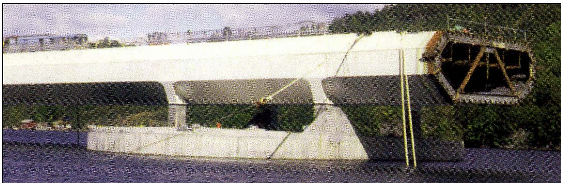
Fig. 12. Un tramo del cajón del tablero sobre un flotador durante su traslado a su posición definitiva. Puente del fiordo de Salhus, Noruega, 1994 [4].
