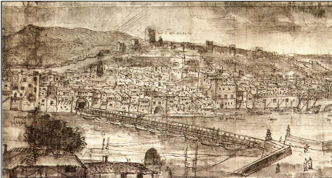
Fig. 2. Puente de barcas de Tortosa sobre el Ebro, s. XVI. Dibujo de A. Van Den Wyngaerde [4].
