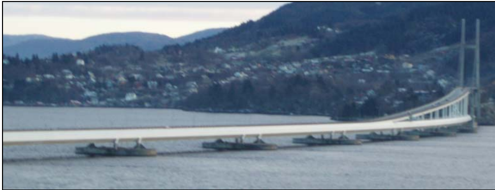
Fig. 7. Puente flotante Nordhordland, Noruega [4].
