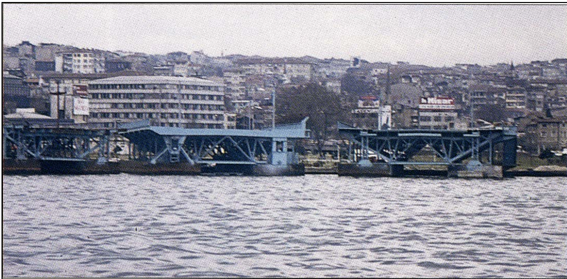
Fig. 4. Piezas del puente metálico en la orilla del Cuerno de Oro, Turquía, una vez desmontado [4].
