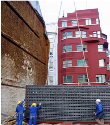
JAULA DE ARMADURA PREPARADA (OBSÉRVESE LA SEPARACIÓN ENTRE BARRAS)
