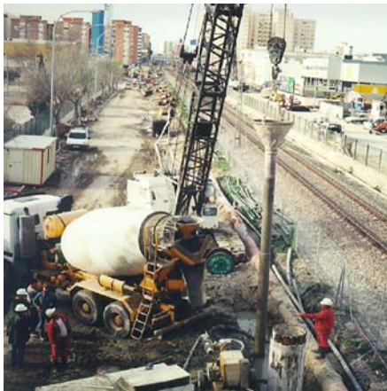
INTRODUCCION DEL TUBO TREMIE EN UN PANEL
