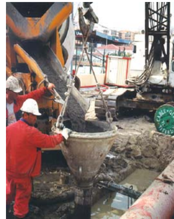
PUESTA EN OBRA DEL HORMIGON
