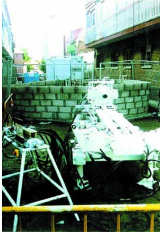
Figura 2.5. INSTALACIÓN Y EQUIPO DE PERFORACIÓN PARA POZO.
