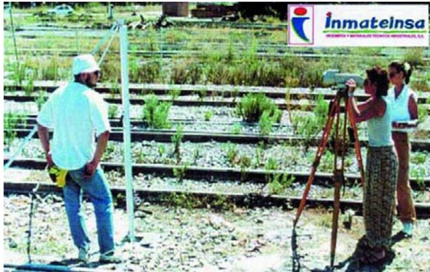
**Figura 3.2. EQUIPO DE NIVELACIÓN TOPOGRÁFICA.**
