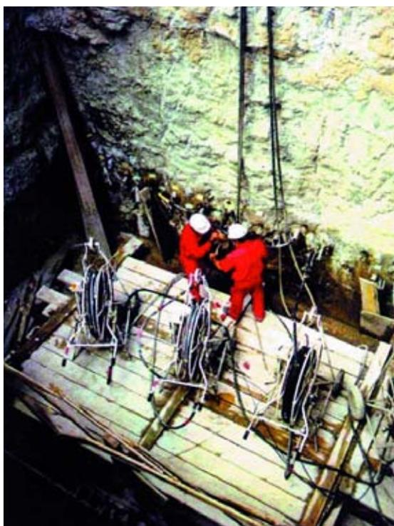
**Figura 2.7. BOMBAS DE INYECCIÓN.**
