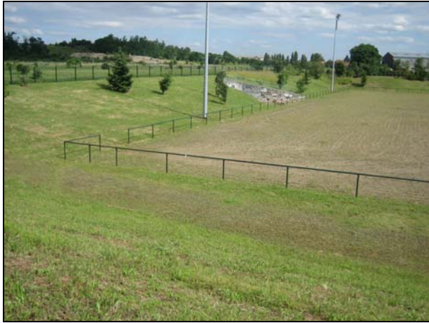
Figura 17. Campo de fútbol integrado en un depósito de detención e infiltración (Lyon, Francia).
