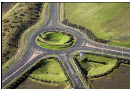
Figura 10. Depósitos de detención en superficie.
