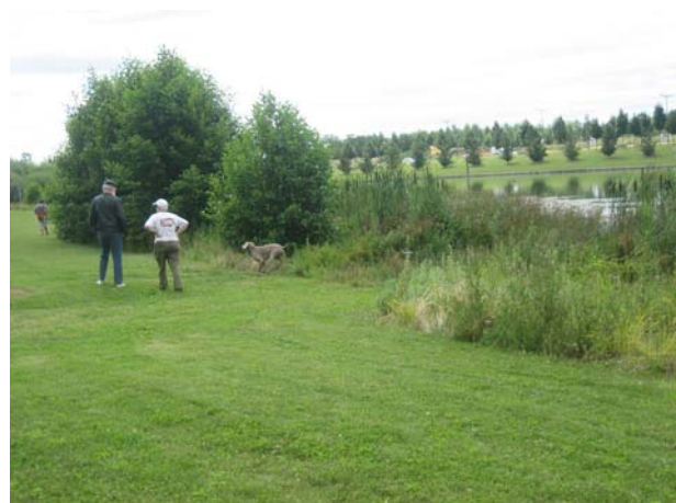
Figura 16. Estanque de retención (Lyon, Francia).
