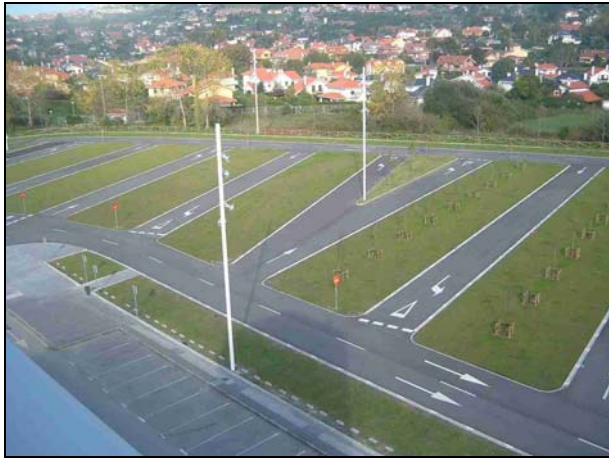
Figura 19. Aparcamiento permeable en Gijón.
