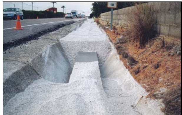
Figura 22. Dren filtrante. Actuación de nivelación de cuneta en Alzira.
