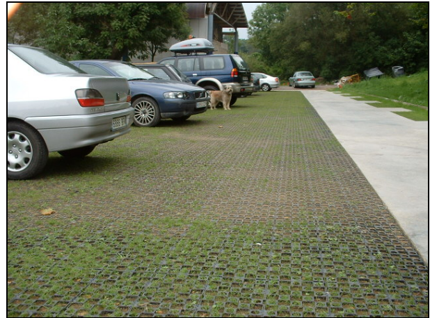
Figura 20. Pavimento permeable en San Sebastián.
