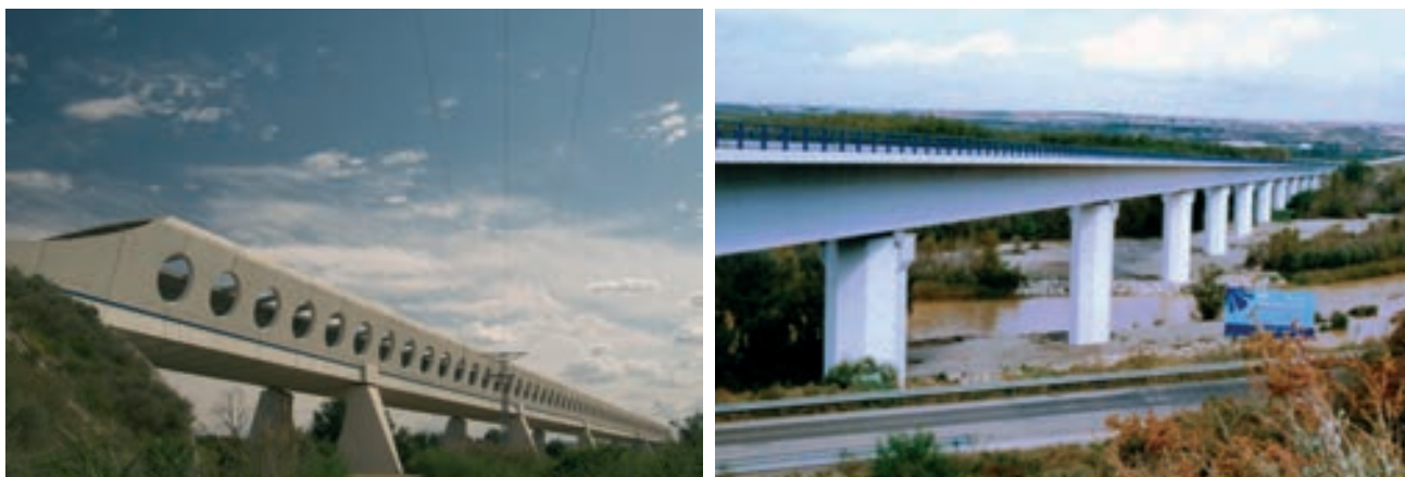
Figura 1. Viaductos sobre el río Ebro y sobre el río Cinca en la L.A.V. Madrid-Barcelona
