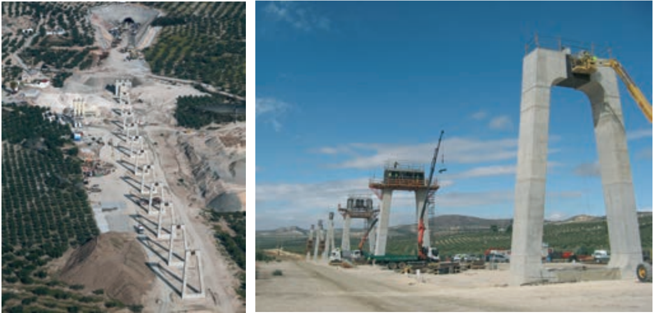
Figura 19. Vista de las pilas durante la ejecución
