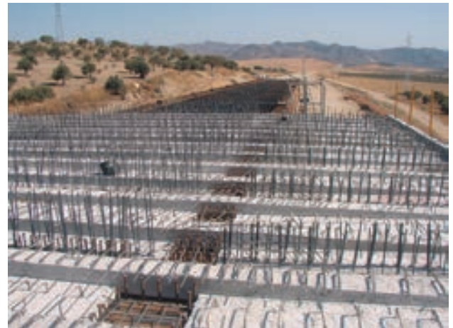
Figura 10. Vista de prelasas superiores
