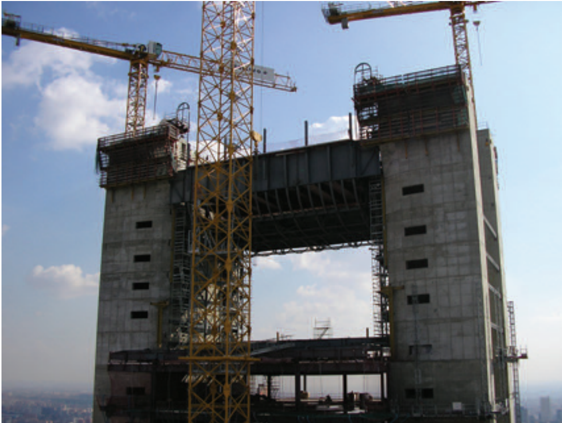
Figura 25. Elevación del entramado de vigas pared y arco de coronación a su posición final. Figure 25. Plate girder and arch level framing lifted into final position.
