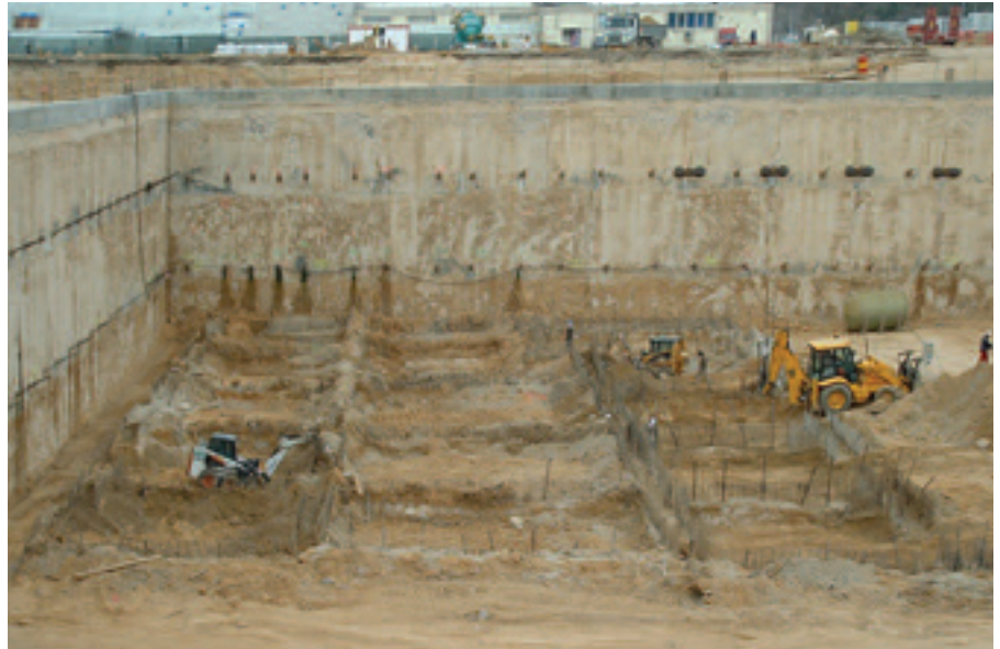
Figura 2. Excavación y muro pantalla. Figure 2. Excavation and diaphragm wall.
