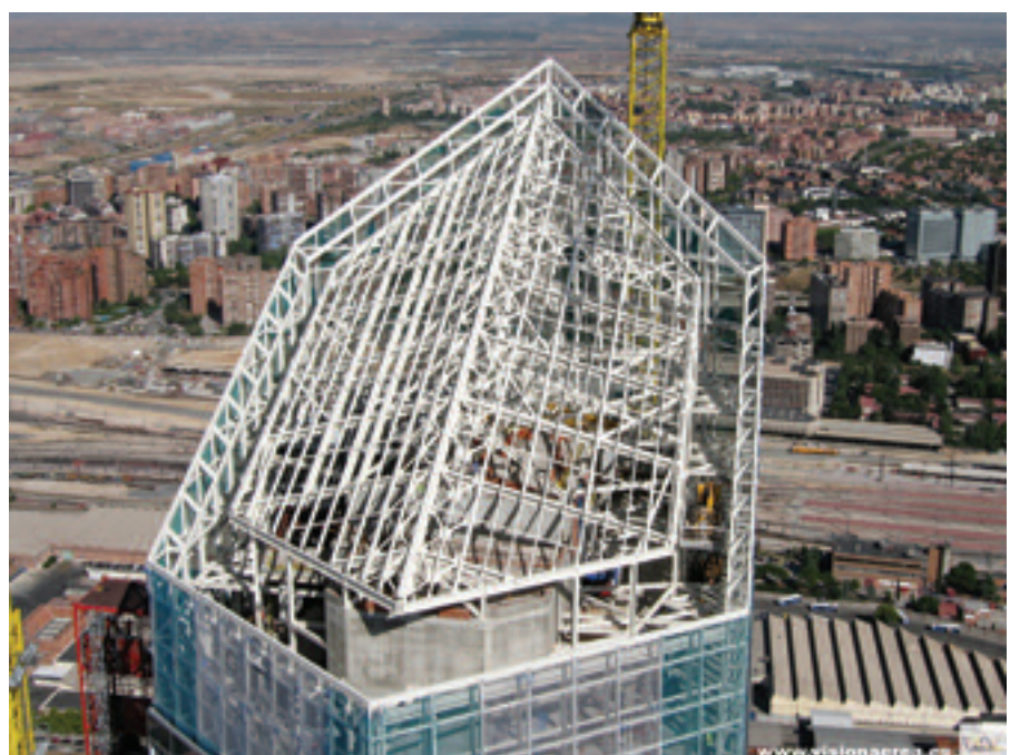
Figura 25. Cubierta. Vista general. Figure 25. Roof. Overview.
