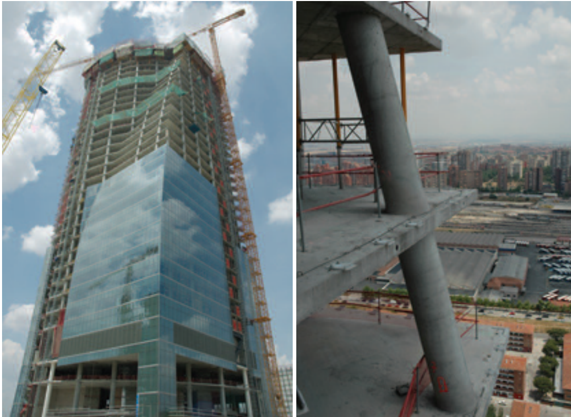
Figura 17. Inclinación de soportes de fachada en la zona media del edificio. Figure 17 . Inclinación of façade supports in the building's mid area
