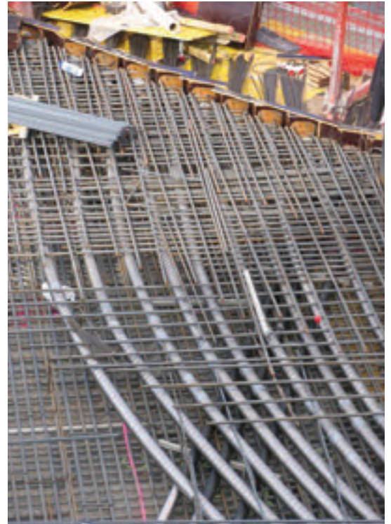
Figura 11. Distribución de cables de pretensado en los forjados del cinturón de rigidez, incluyendo los cables necesarios para los desvíos de soportes (izqda.); detalle con la colocación de los cables y sus anclajes en el forjado (dcha.) Figure 11. Prestressing cable layout in the stiffness belt's slab floors, including the cables necessary for support diversions (left); detail with the placing of cables and their anchorages in the slab floor (right)
