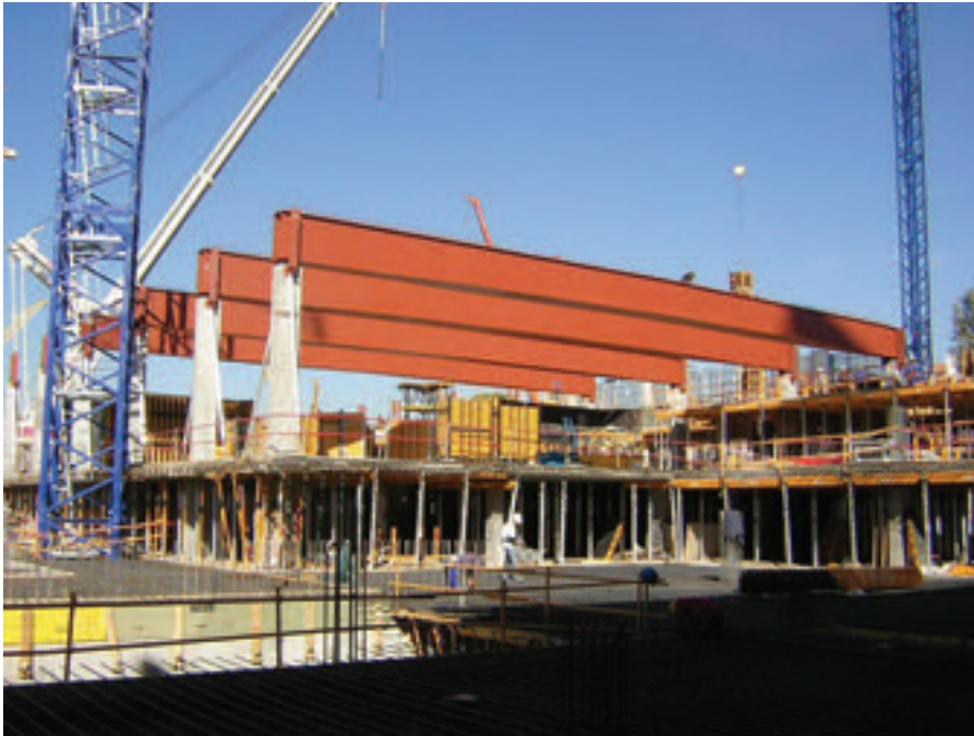
Figura 27. Estructura de forjados de hormigón armado en las plantas bajo rasante y vigas metálicas del salón de convenciones.
