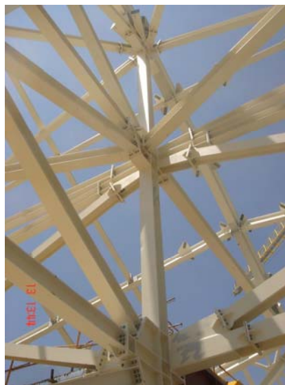
Figura 10. Estructura metálica de coronación.
