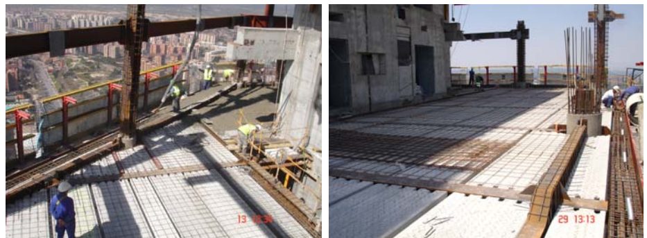
Figura 8. Forjado de losas alveolares sobre emparrillado de vigas metálicas.
