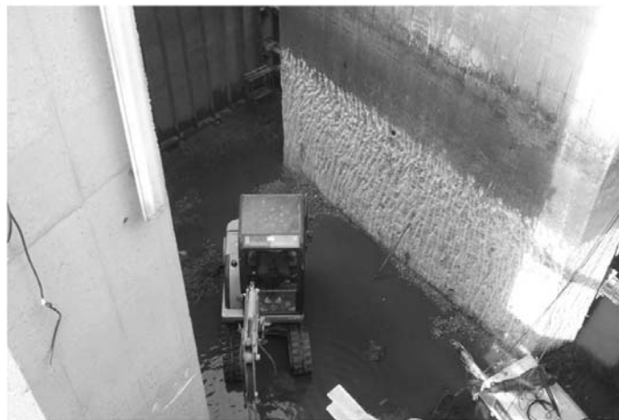
Figura 20. Vista del espacio entre fustes de la pila. Se distingue la superficie áspera
