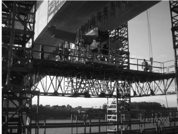
Figura 29. Colocación de la estructura metálica
