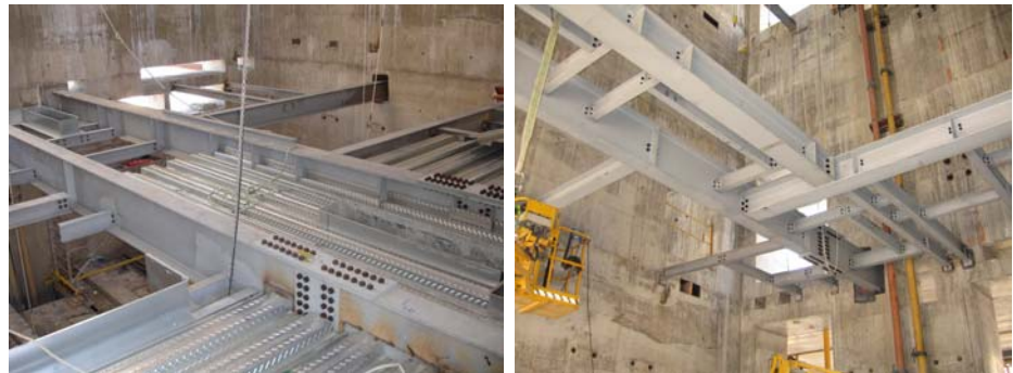
Figura 7. Forjados de chapas nervadas mixtas, para el interior del núcleo
