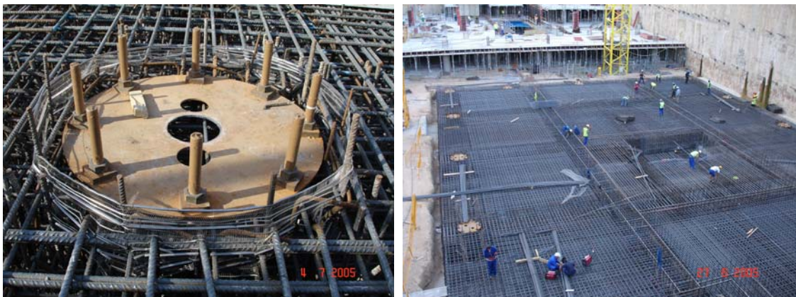
Figura 3 - Losa de cimentación de la Torre de Cristal de Madrid. Vista general y arranque de uno de los pilares mixtos.
