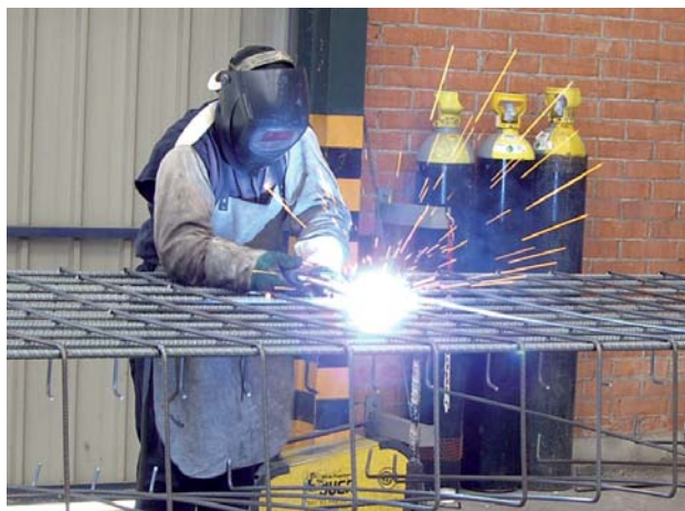
Figura 1.- Soldadura en la elaboración de armaduras pasivas.
