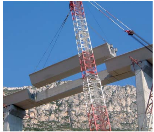
Figura 5.- Situación transitoria durante la colocación.
