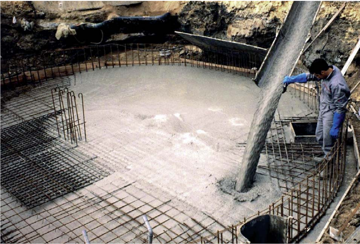
Figura 1.- Ejecución de una losa con hormigón autocompactante.
