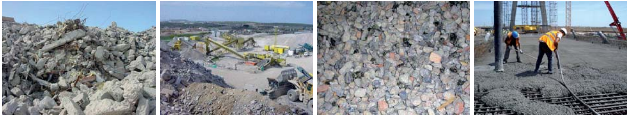
⇒ Figura 10.- Residuos de hormigón, planta de tratamiento, árido reciclado y colocación de hormigón reciclado en el tablero del nuevo puente atirantado de Manises.
