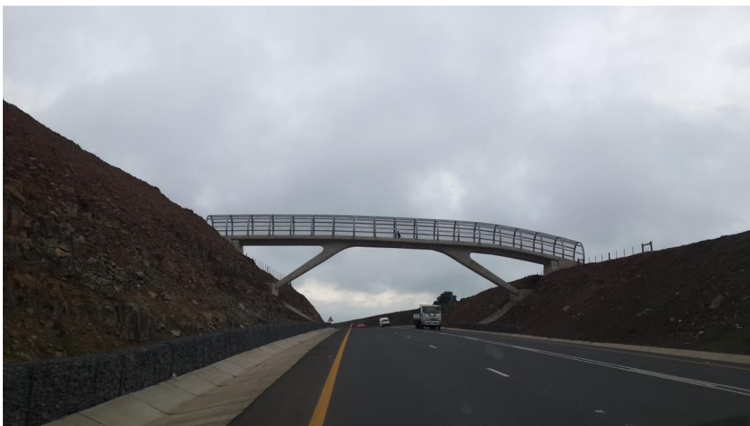
Figura 14. Instalación peatonal ejecutada
