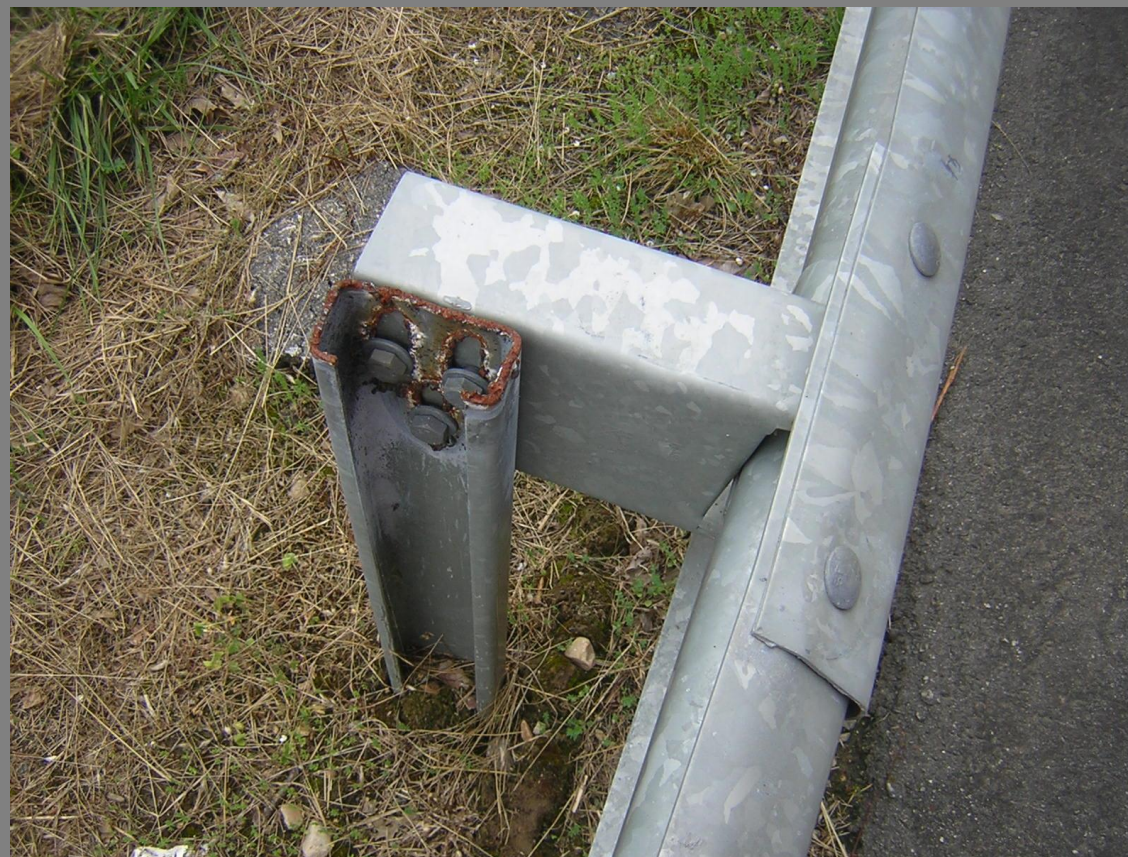
Poste cortado con taladros efectuados in situ
