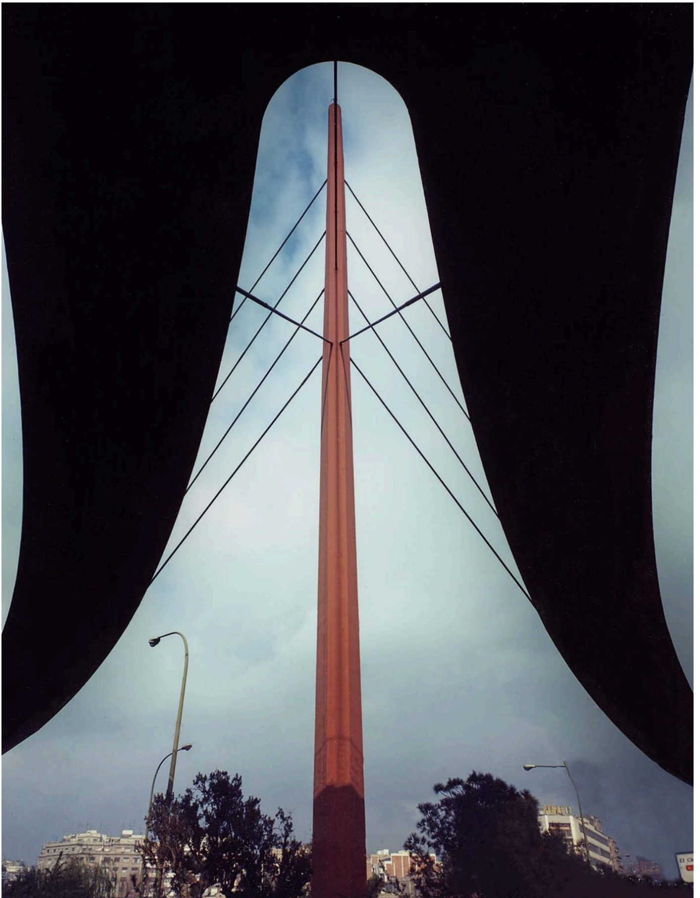
Pasarela de Las Glorias. Barcelona, España, 1974
