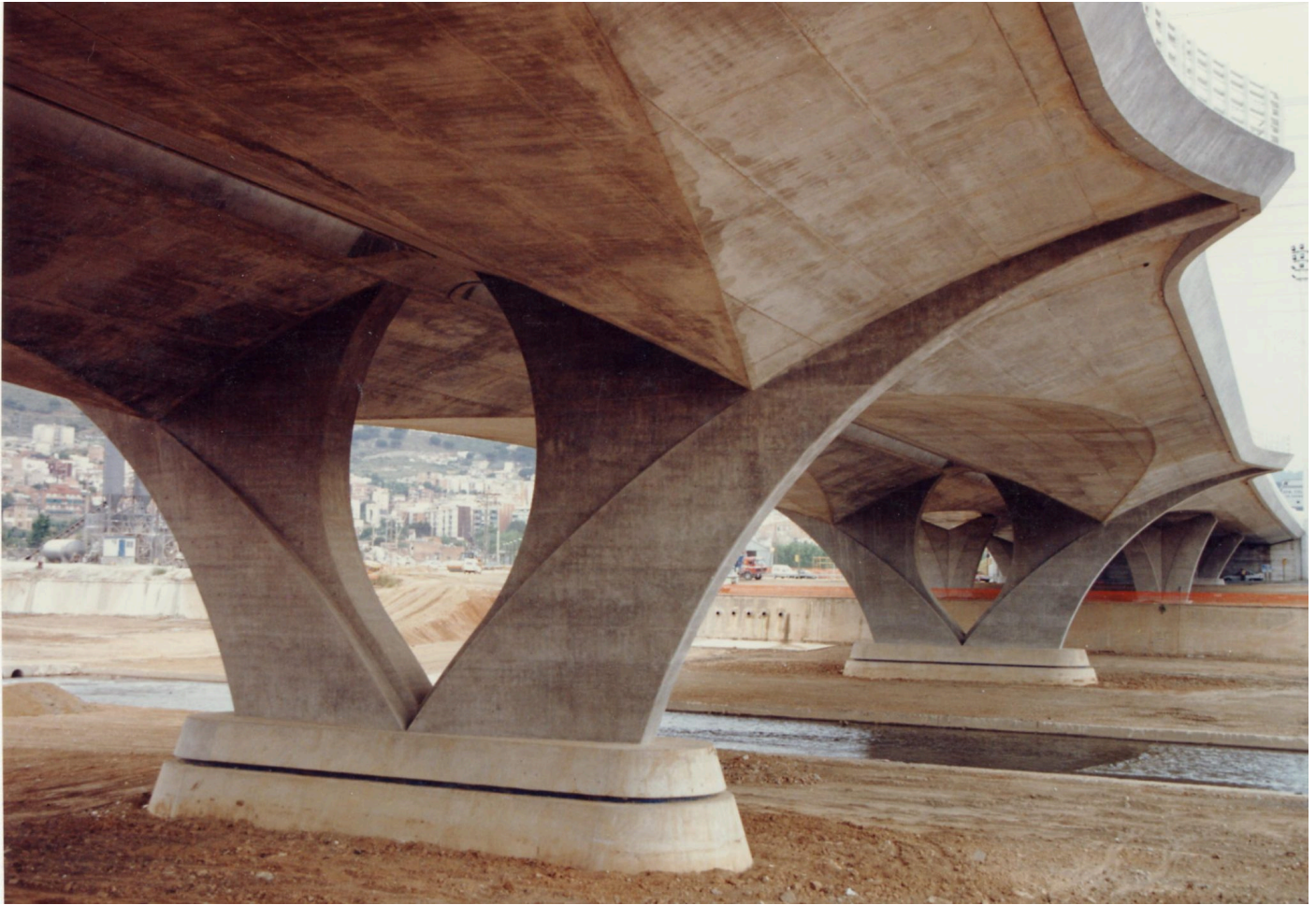
Puente sobre el río Besos en la Autovía Trinidad-Mongat. Barcelona, España, 1989.
